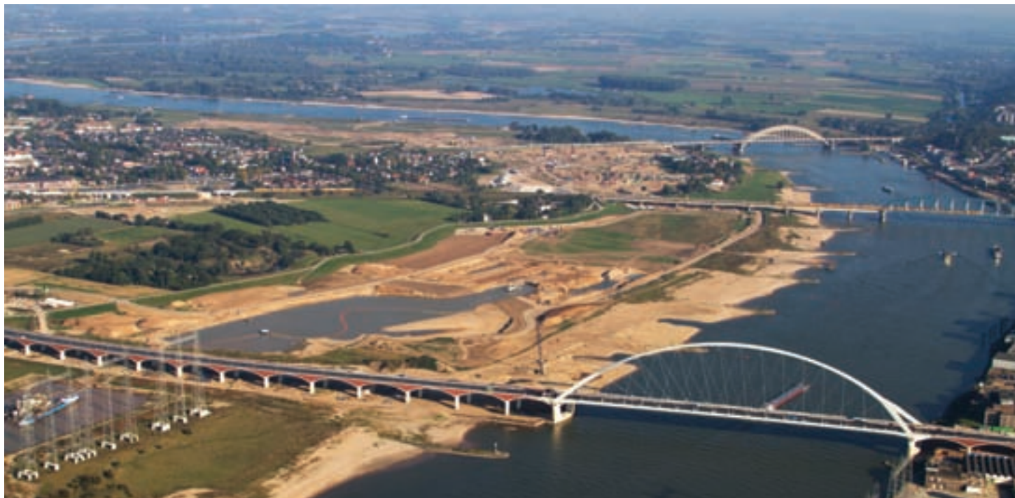
Parallel aan de Waal wordt een nevengeul gegraven waarbij tien vierkante kilometer land wordt onttrokken om meer ruimte te bieden aan het water en om overstromingen in de toekomst te voorkomen. Het is een groot gebied waar belangrijke netwerken en cruciale noord-zuidverbindingen doorheen lopen. Foto: Waterschap Rivierenland
